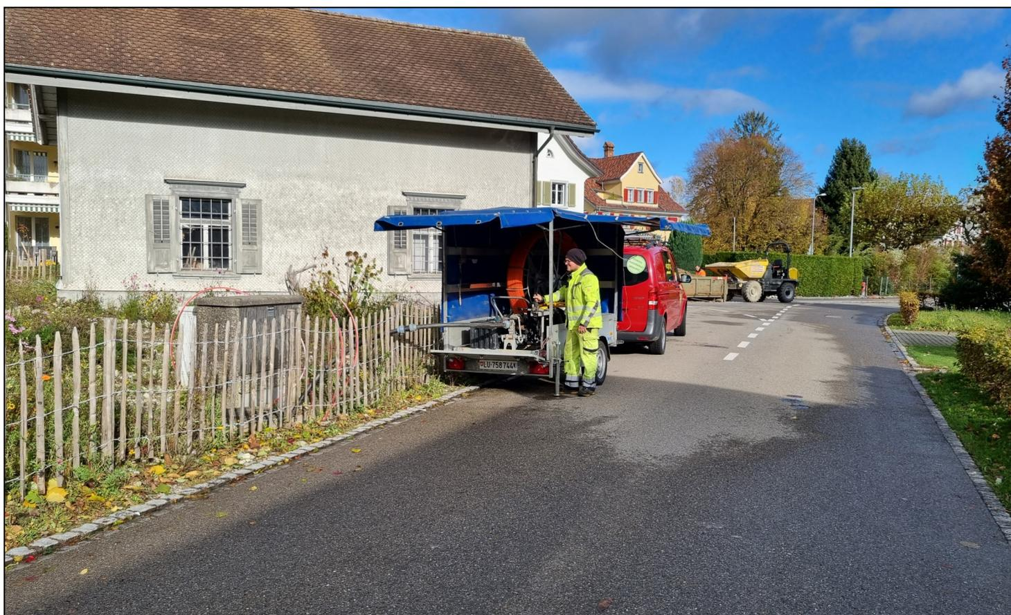
Der Ausbau des Glasfasernetzes ist in vollem Gange. Hier die Firma Wäger AG beim Einzug der Speedpipes.
